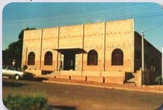
Construção da Igreja
